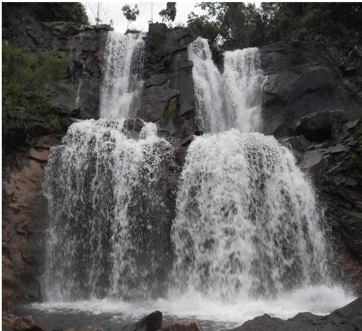
Cachoeira Hidroelétrica Jatapú - Caroebe – RR.
