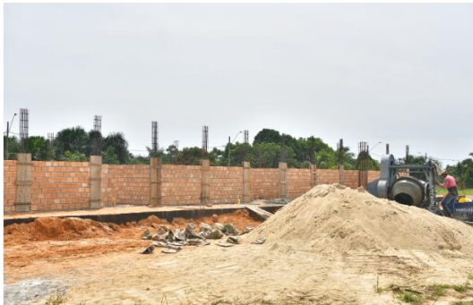
Escola Municipal Domingos Gomes de Freitas
